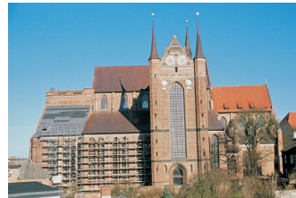
St. Georgen Wismar, Westansicht
