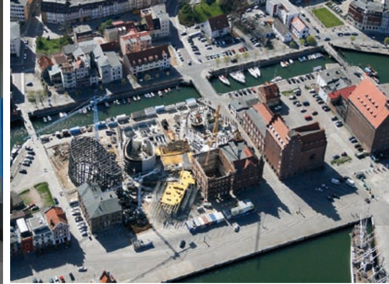
Blick auf die Baustelle Februar 2007
